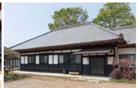
N邸／奇襟造りの屋根に漆喰と彫子下見板張りの外観
