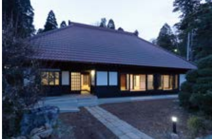
T邸／茅葺き屋根を銅瓦に葺き替えた外観
