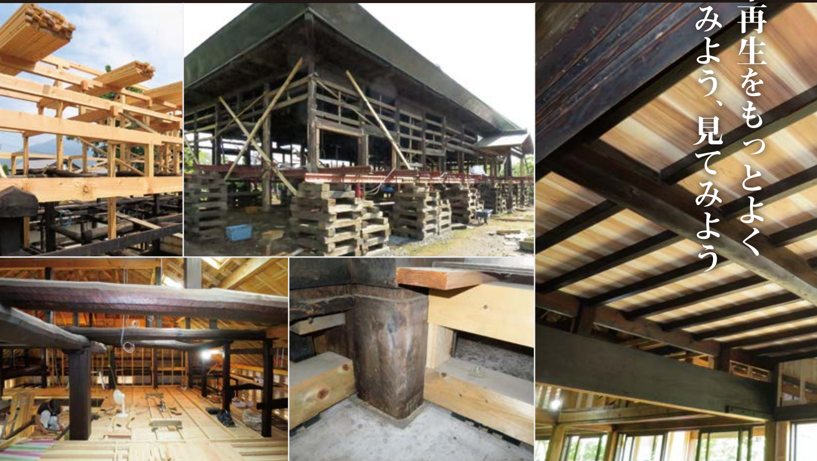
上記の写真は見学します古民家再生の工事写真です
