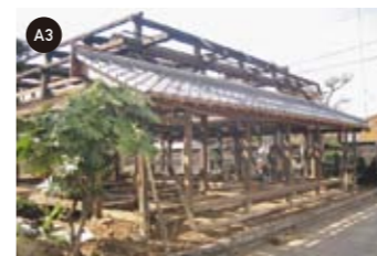
解体工事 ：物件によって解体範囲は異なる。既存の梁、柱などを残し、壁、天井、床組みなどを撤去する。
