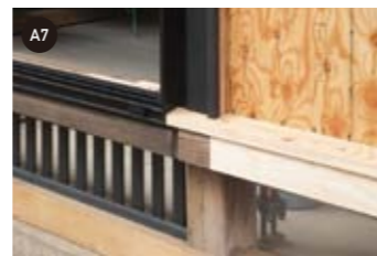
継ぎ手等の補修 ：解体時に部材に腐朽や痛みがあった場合、できるだけ同材で補修して使う。
