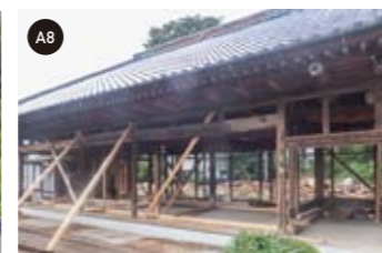
建て起こし ：柱が傾いていたり変形した建物を、ワイヤーやジャッキを使って、元の垂直の状態に少しずつ戻す。
