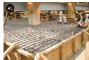
基礎工事 ：揚げ屋工事後、新しい基礎を作り、不同沈下等が起きない強固な建物とする。
