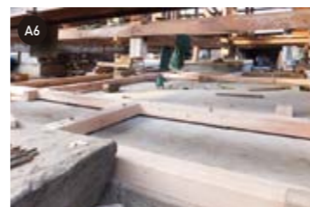
土台敷き ：基礎の上に新たな土台を敷く。
