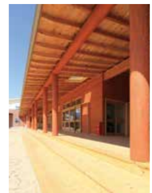
檜・杉で作った緑側的なテラスは、外と中を緩やかに繋ぎます。
