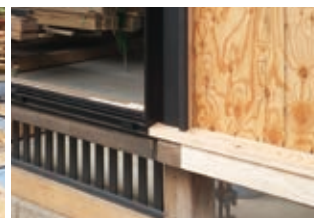
継ぎ手等の補修
