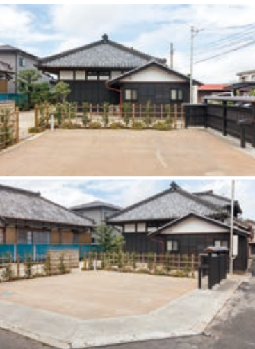
右) 門より入って正面に主屋を見る。手前右側にヒンブンが見え、その奥が駐車スペース(辻的な空間)。左上) 駐車スペースは町並みの連続性のために黒板塀を設け、その袖に四つ目垣を設けて主屋と緩やかに仕切っている。左下) 茨城県産の真砂土を使用した土の舗装。外側はコンクリート洗い出し仕上げ。乗り入れ部分は礎石の再利用した御影石
