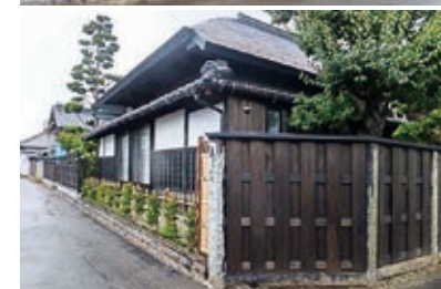
上) F邸の東側、欄間付板塀、四つ目垣に植栽 下) 北側は御影石の支柱と杉板塀
