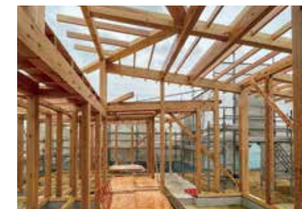
工事現場 材木が丁寧に組み上げられた上棟式の様子
