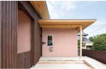
走って転んでも安全安心な土の舗装とスロープ
